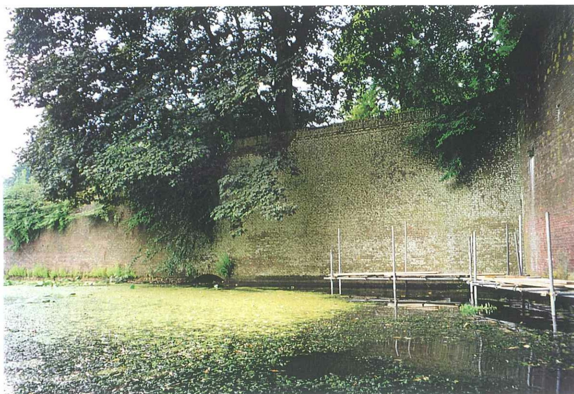
Afb. 16) Aanzicht van de uitspringende toren tijdens de veldwerkzaamheden.
