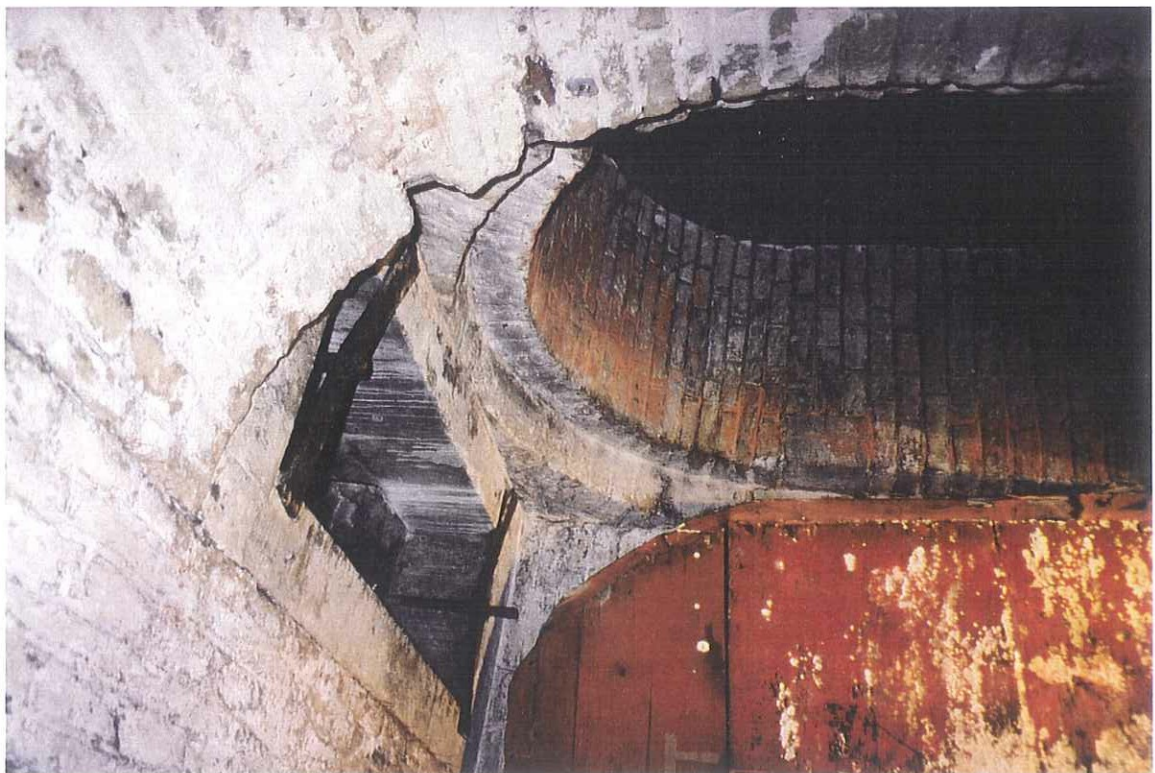
Afb. 28) Door natuursteen omgeven venster ten behoeve van de ontluchting in het kruitmagazijn. Afb. 29) Oorspronkelijke opening in het gewelf van het gangetje.
